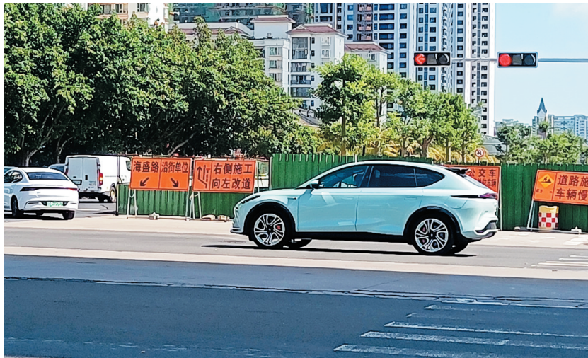
永万路改造项目右侧半幅道路仍是封闭施工状态
