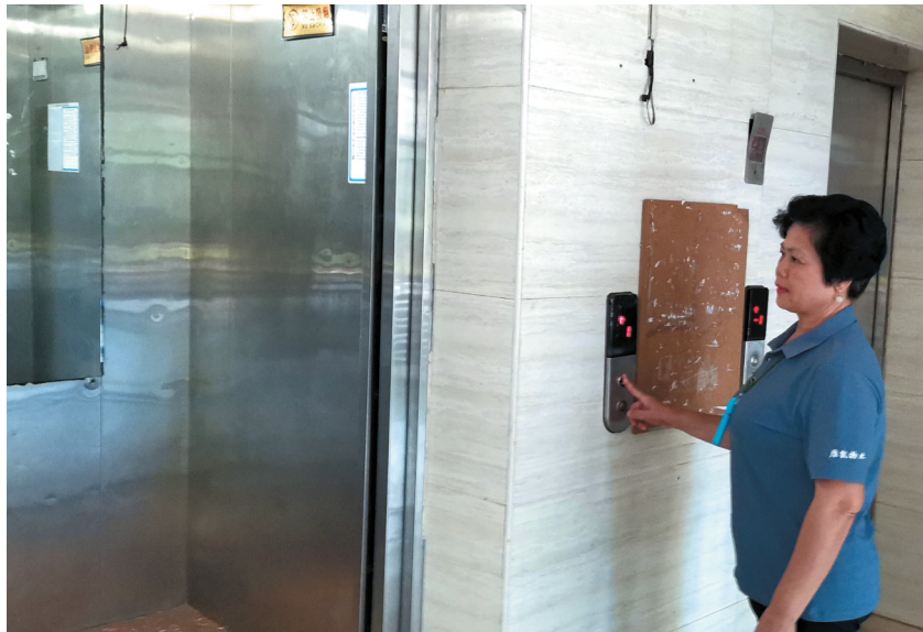
小区暂时避免停电,业主乘电梯出入更有保障。
