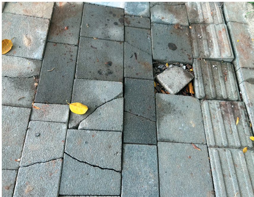
博爱南路海口公园段靠近湖边一侧的人行道出现地砖破碎、翘起、松动。
