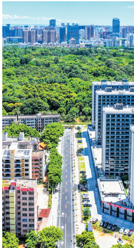
航拍打通的“断头路”。（龙华区新闻中心供图）
