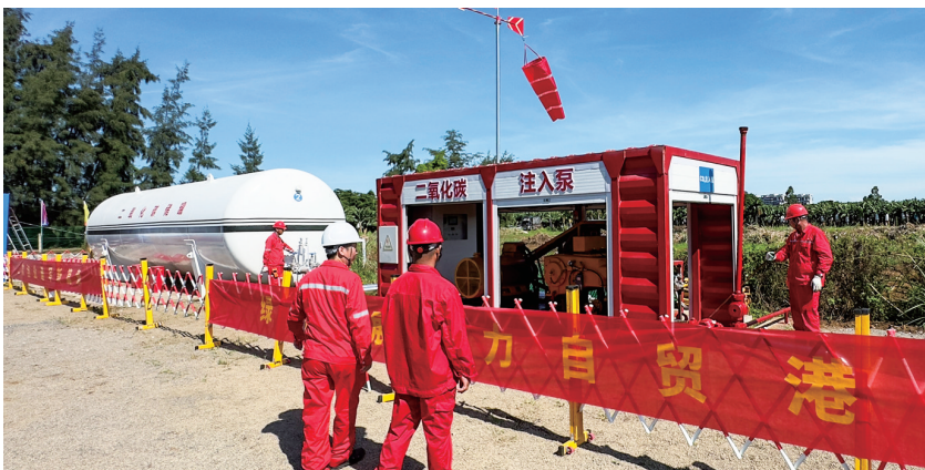
7月12日,我省首个咸水层CCS试注项目在海口正式启动。
