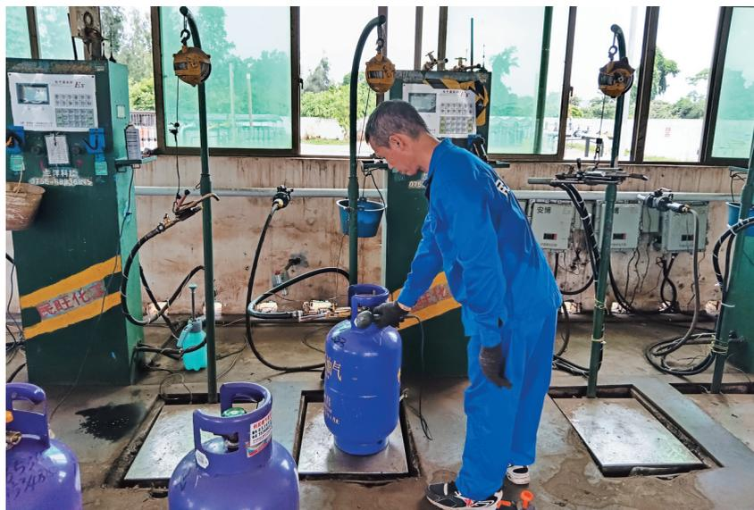
工作人员用海口市智慧燃气监管系统App端扫气瓶二维码，做好充装检查
