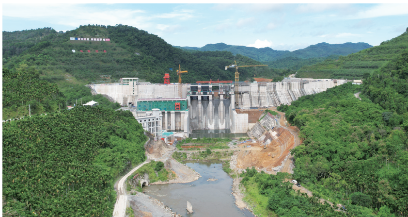
海南迈湾水利枢纽工程主体大坝全线封顶。通讯员郑开旭供图
