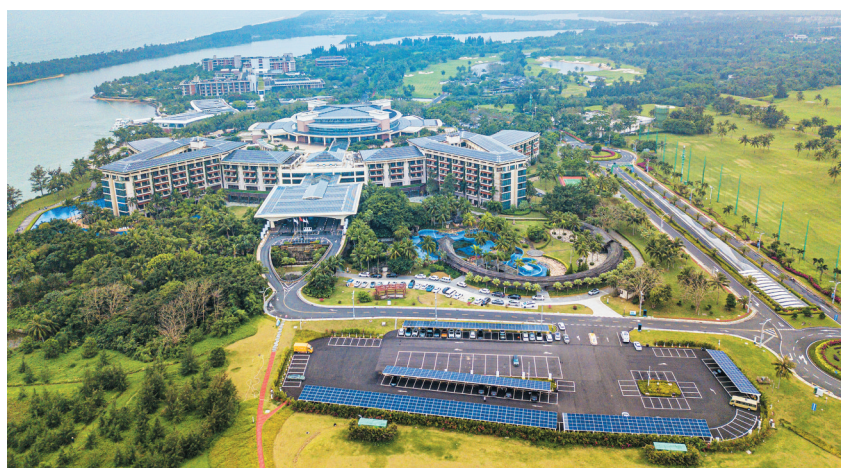
博鳌近零碳示范区(无人机照片,2024年3月9日摄)。新华社发
