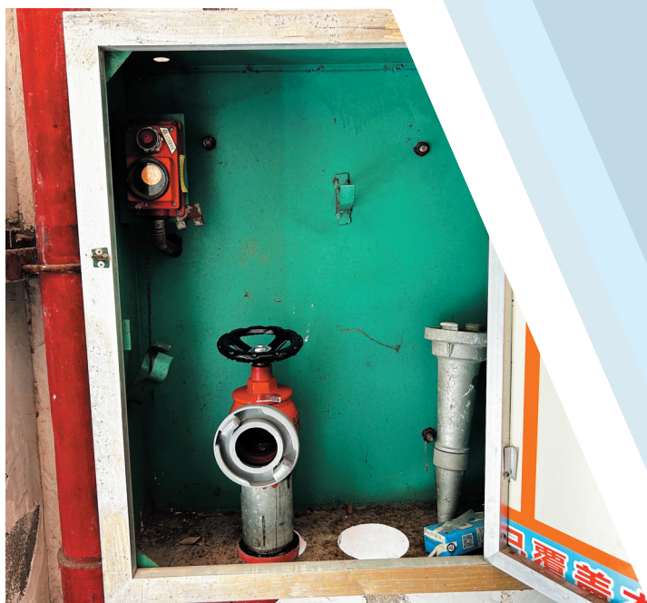
消防灭火箱里更换过消防栓阀门,未见消防水带。
