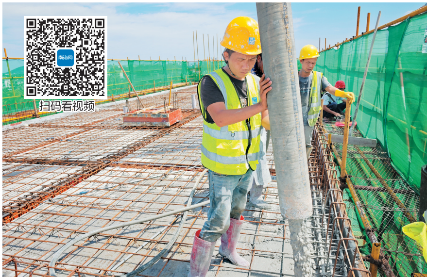
工人进行最后一方混凝土浇筑,项目实现全面封顶。(施工单位供图)
