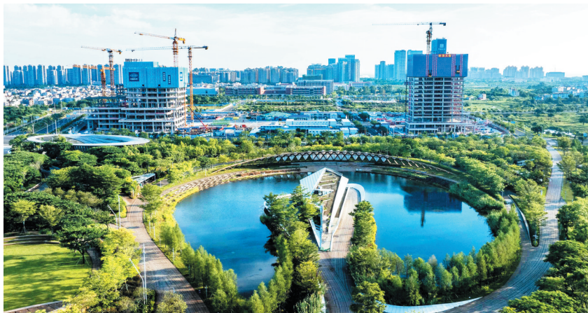
项目施工现场。
