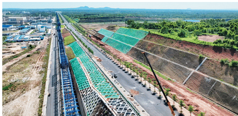
正在修建的新道路。(洋浦政务供图)
