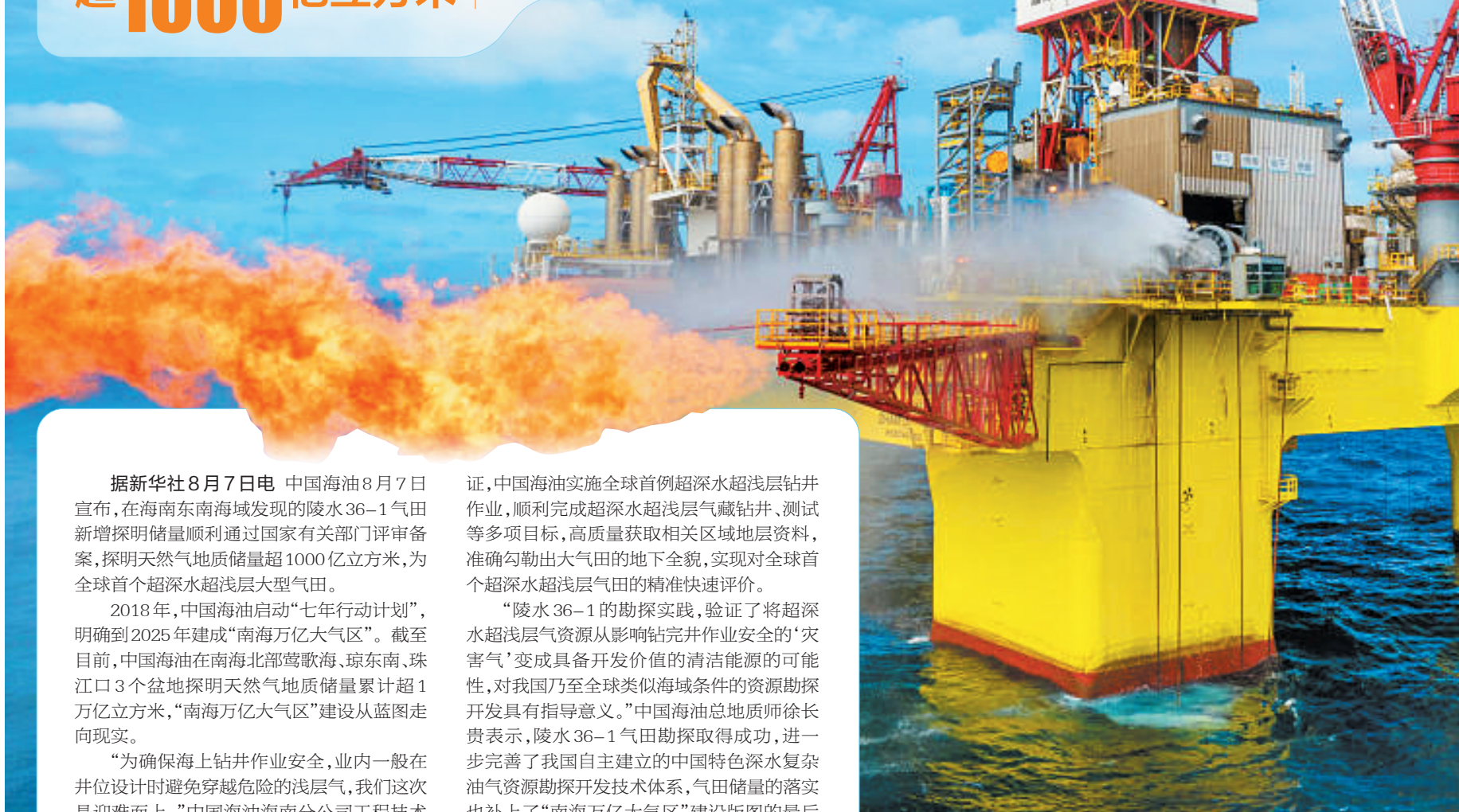
图为对陵水36-1气田进行测试作业。(中国海油供图)
