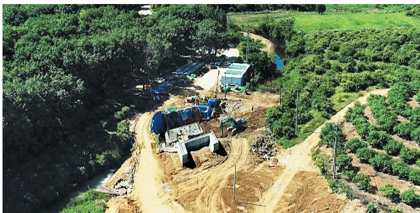
东方危桥改造项目施工现场。(东方融媒供图)
