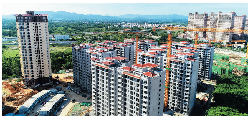
东方市鸿坤理想海岸安居房项目。东方融媒体中心供图
