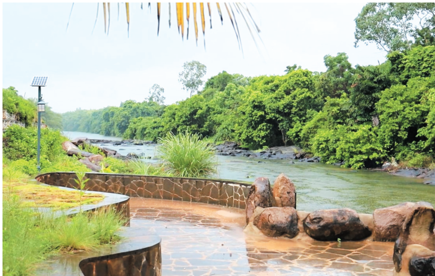
定安春内村水系连通及水美乡村建设试点项目。
