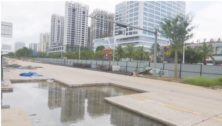
围挡起来的永万路半幅道路破除了部分老旧受损水泥路面
