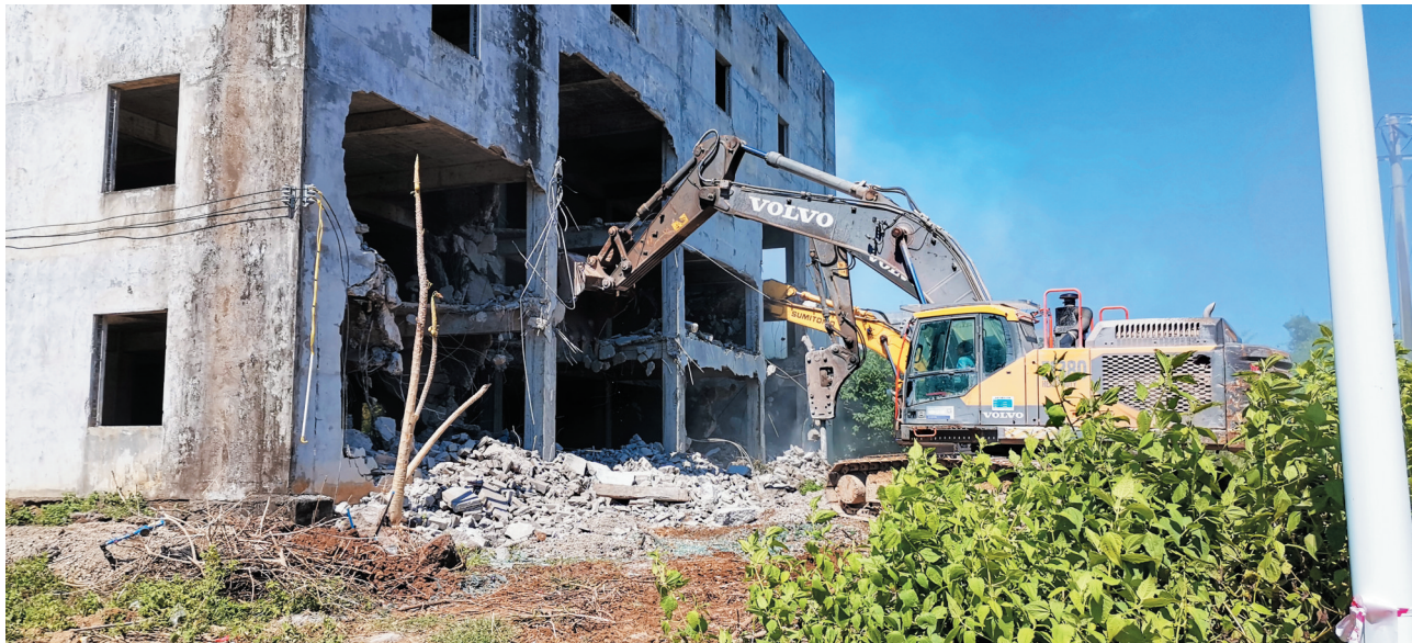
挖掘机对项目内已完成征收的楼房进行拆除。
