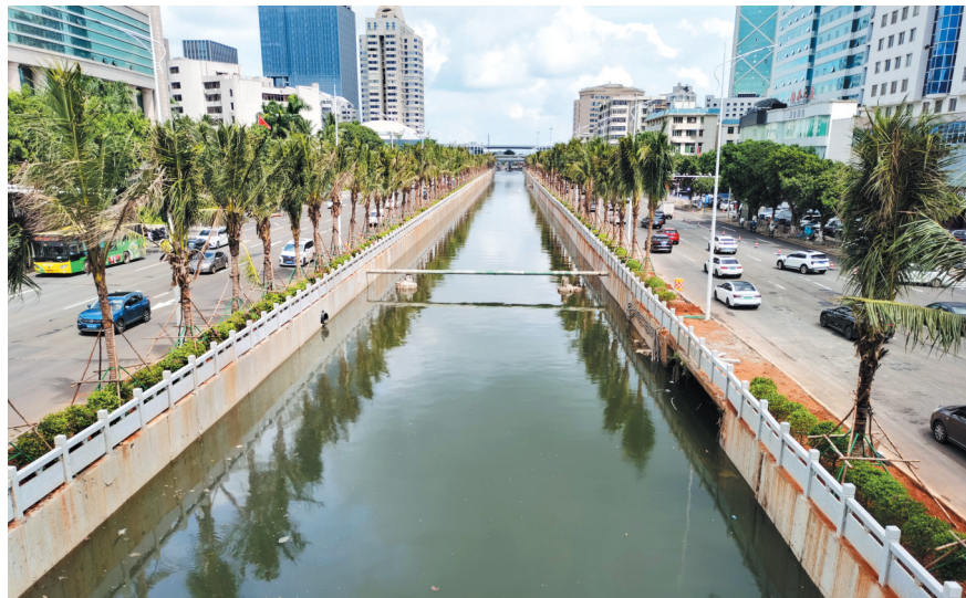
龙昆沟河道两侧道路恢复车辆正常通行。
