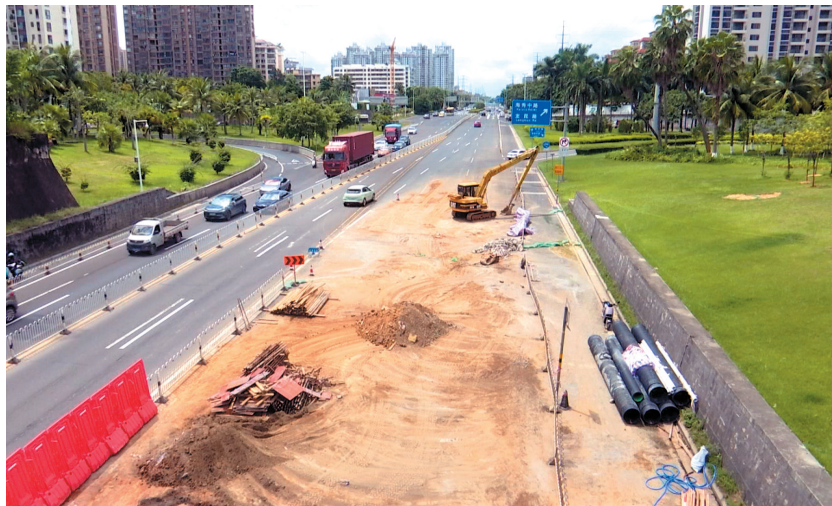
塌陷路面已经完成回填和混凝土浇筑。
