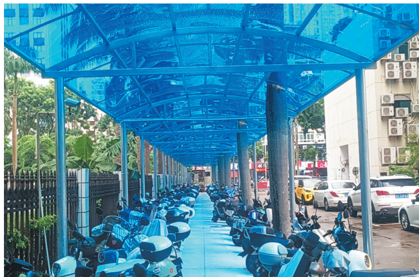
小区使用公共区域建设电动车棚。(小区业主供图)
