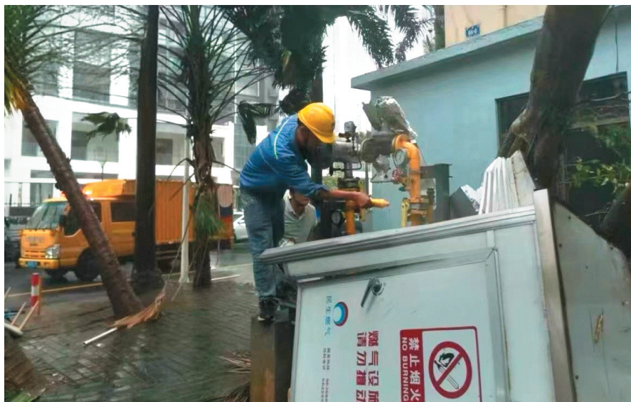
民生燃气工作人员正在抢修线路。
