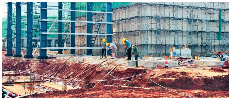
项目施工现场。
