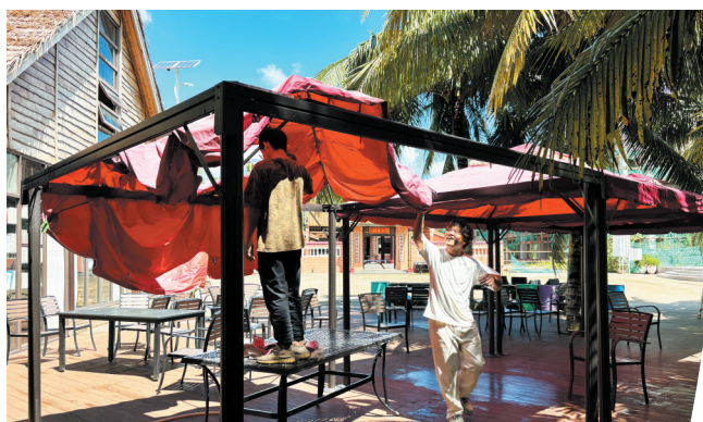
重兴斑兰农庄修建恢复。
