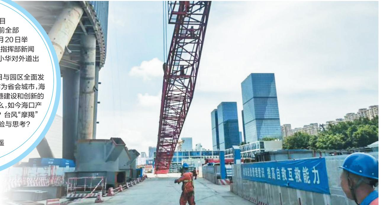
海南中心项目在台风“摩羯”来临前拆除塔吊大臂。（项目方供图）
