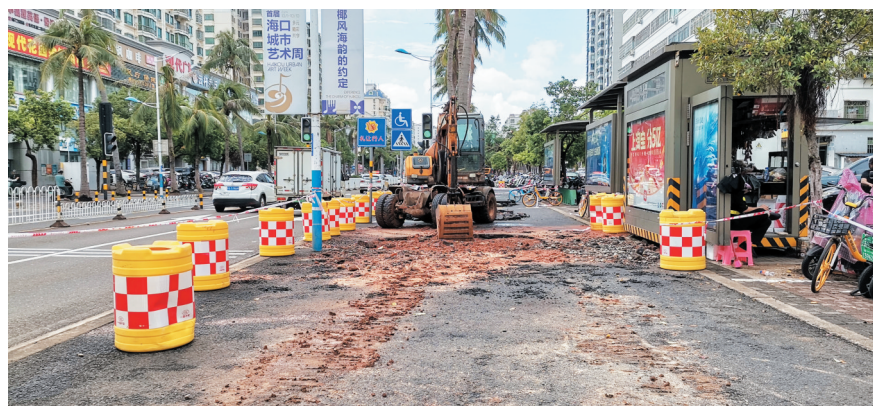
海德路北侧正在施工。(记者 王康景 摄)
