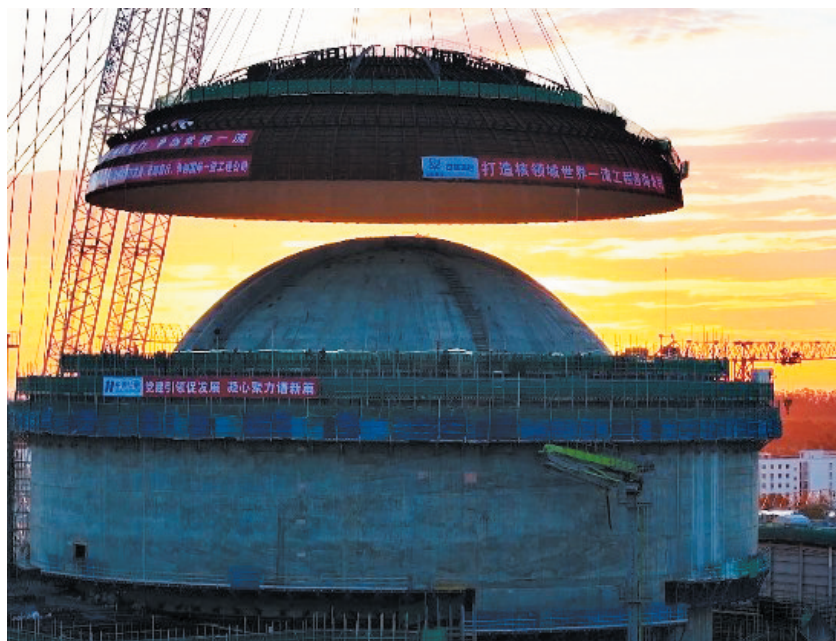
吊装现场。通讯员 王学武 摄
