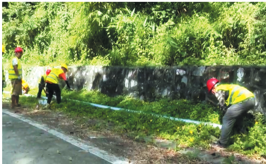
施工现场。(图片均由五指山市融媒体中心提供)
