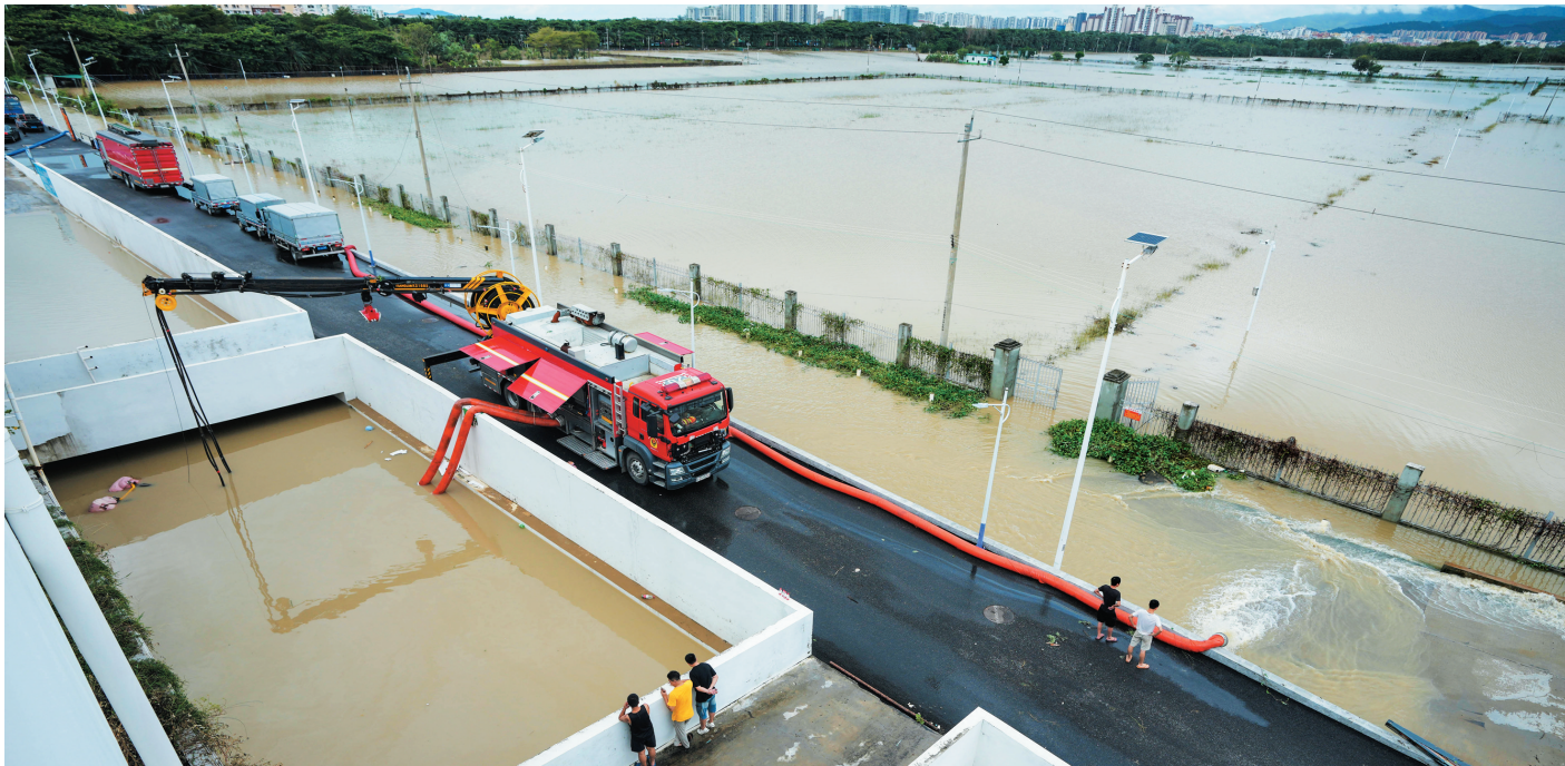
10月29日,三亚市南果农产品批发市场,消防救援力量对地下车库21万立方米的积水进行排涝工作。(海报集团全媒体中心记者 王程龙 摄)
