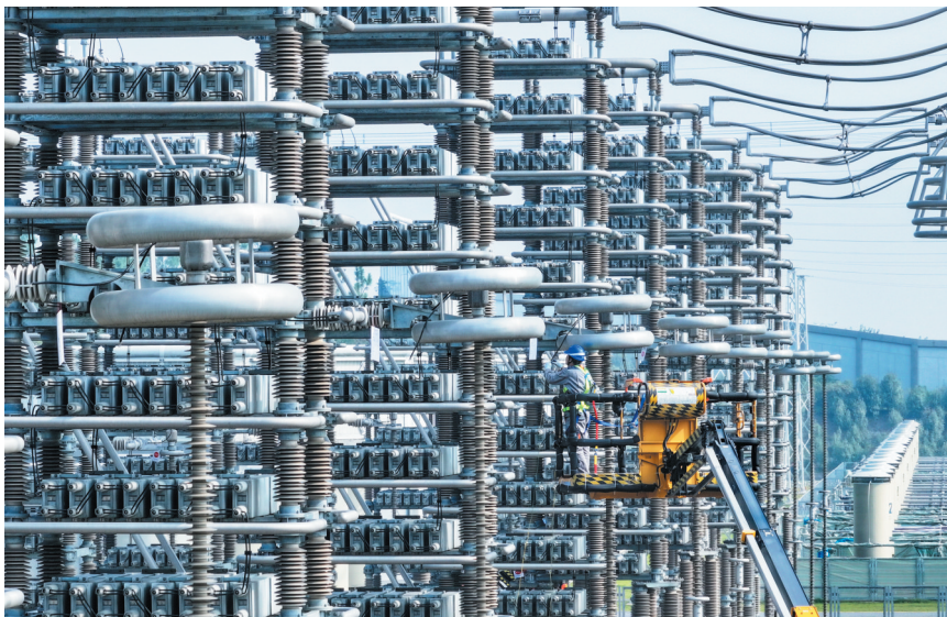
10月29日，国网安徽电力检修人员对古泉换流站设备检修、维护
