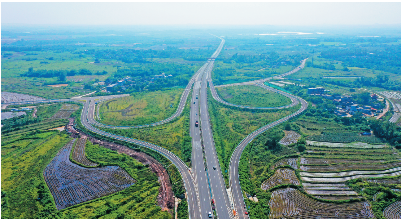
11月1日,记者航拍万洋高速王五互通。记者 汪承贤 摄
