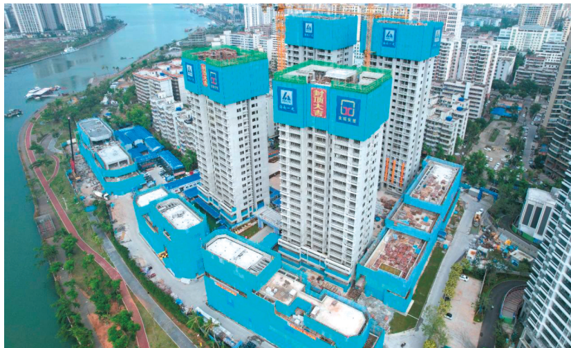
海口市城市更新项目金城·金甸水岸封顶。
