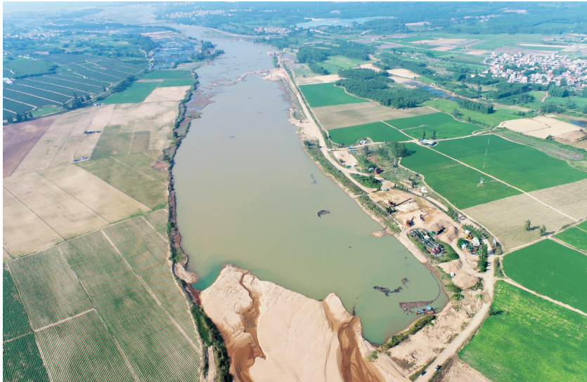
航拍昌化江下游。(海南河道公司供图)
