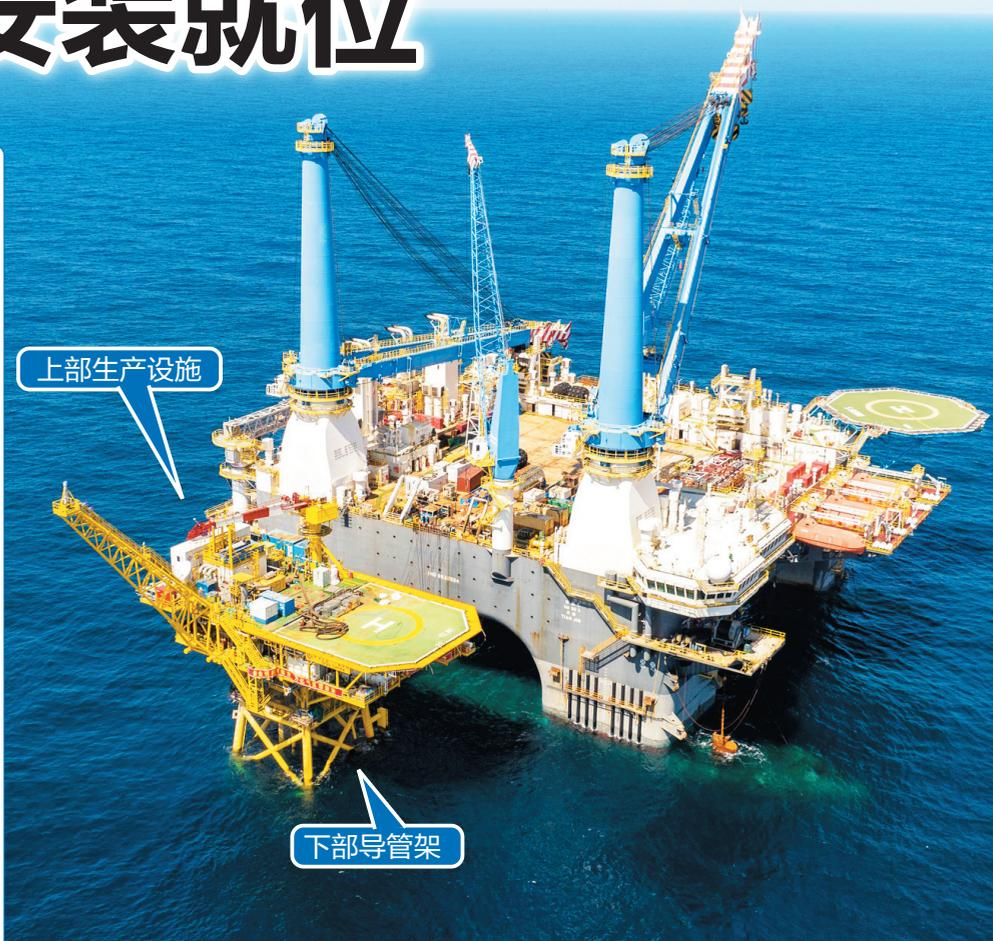
东方29-1平台安装就位,平台由下部导管架和上部生产设施组成。(中国海油供图)
