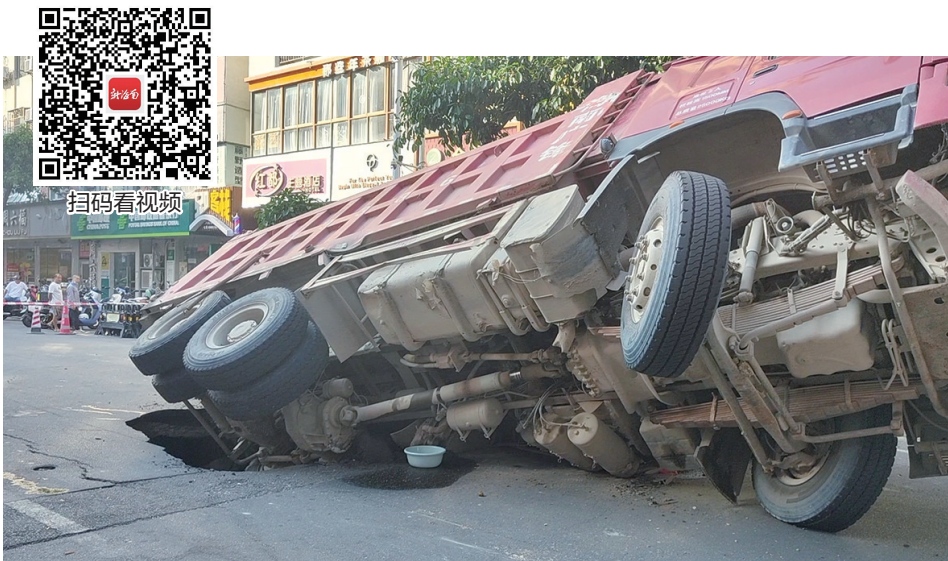
在三亚商品街一巷港华广场附近,路面发生塌陷,货车侧翻被困
