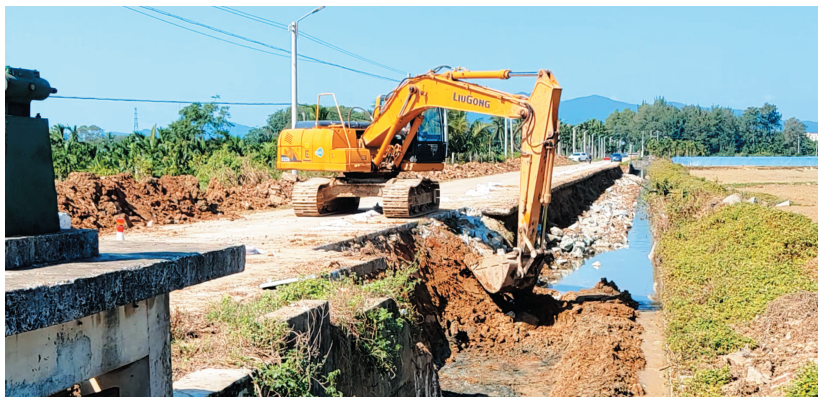
万宁山根镇文容村水毁设施修复现场。(记者 张野 摄)
