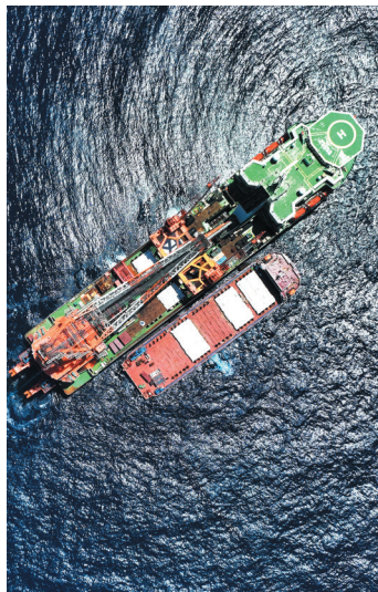
“海洋石油201”在进行海管铺设作业。(新华社发 韩庆摄)
