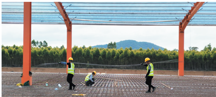
工人正在搬运建材。
