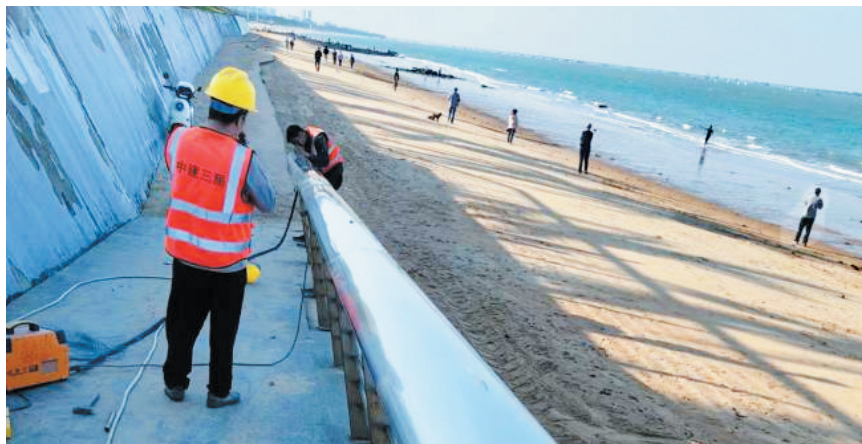
工人修复护栏。(海旅公司供图)
