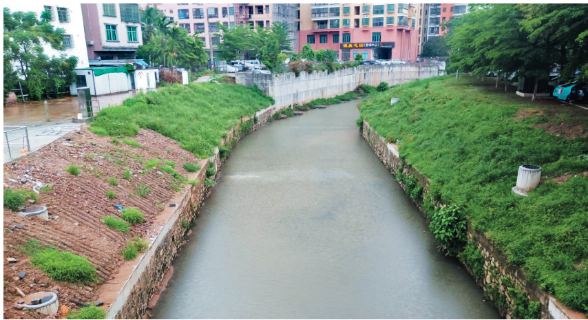
整治后的双沟溪。
