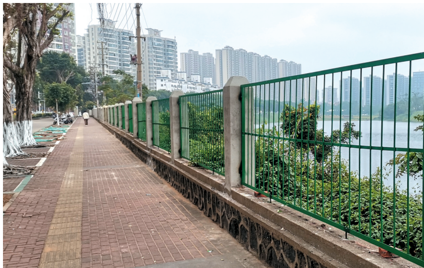
破损的沿湖护栏已经完成修复。
