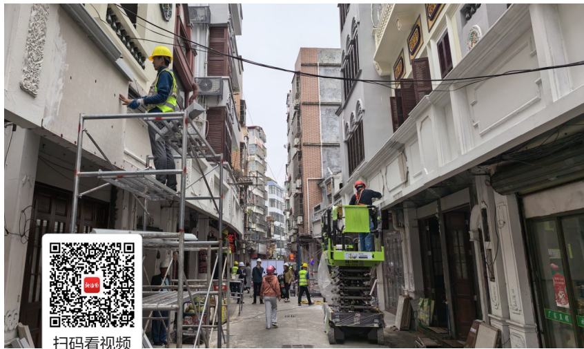
打铁巷正在改造升级。
