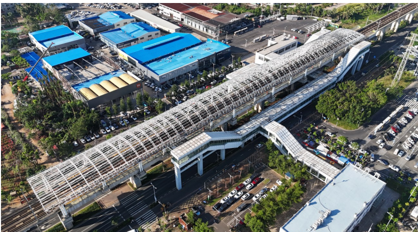
修缮中的站台雨棚。通讯员供图
