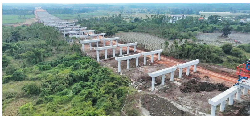
光村水河特大桥施工区。(受访者供图)
