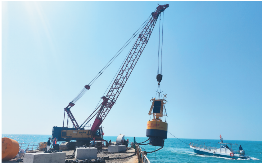
1月6日,项目现场正在投放海底监控设备。
