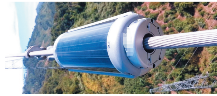
▲分布式故障定位装置。(海南电网公司供图)
