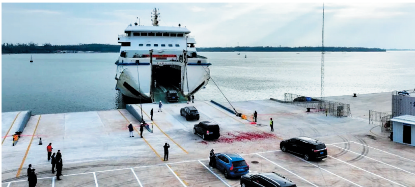
15日海安港应急客滚泊位发出第一个航班,图为首航装船作业。徐闻港供图
