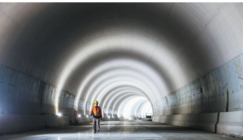
1月16日，施工人员行走在15.07米超大直径广州海珠湾隧道东线盾构隧道内
