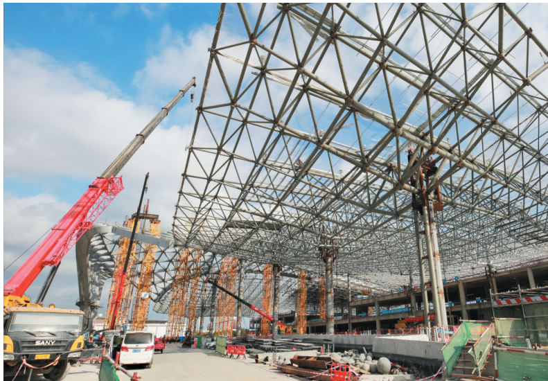
三亚凤凰机场三期改扩建项目T3航站楼施工现场。海南机场供图
