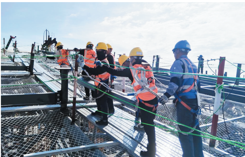
2月4日,工人正在三亚凤凰国际机场三期改扩建项目T3航站楼屋面施工。(中建三局供图)
