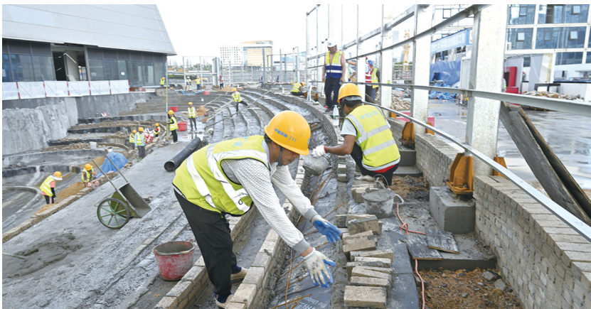
海南中心项目施工现场。海南机场集团供图
