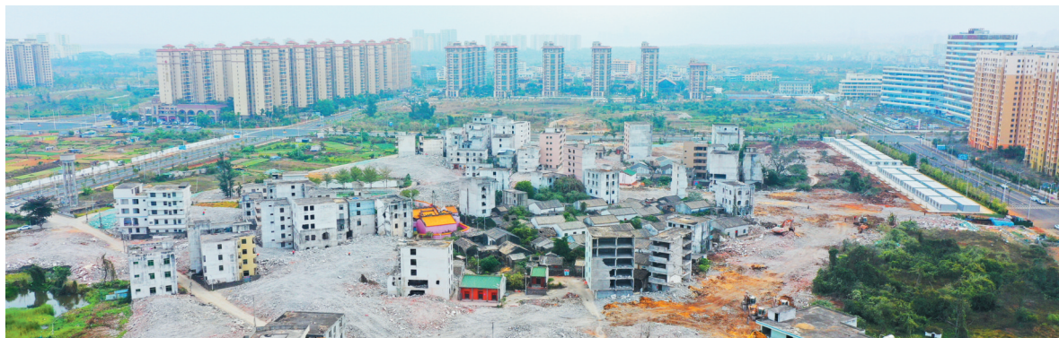
田罗新民城市更新项目施工现场。(记者 汪承贤 摄)
